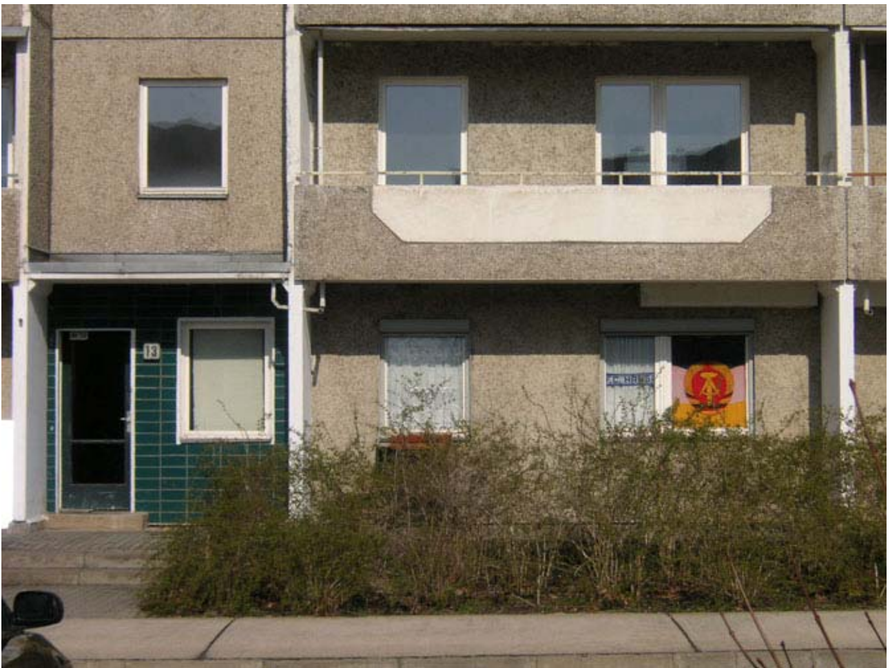
Foto 2: Rückbau einer Plattensiedlung in Eisenhüttenstadt
